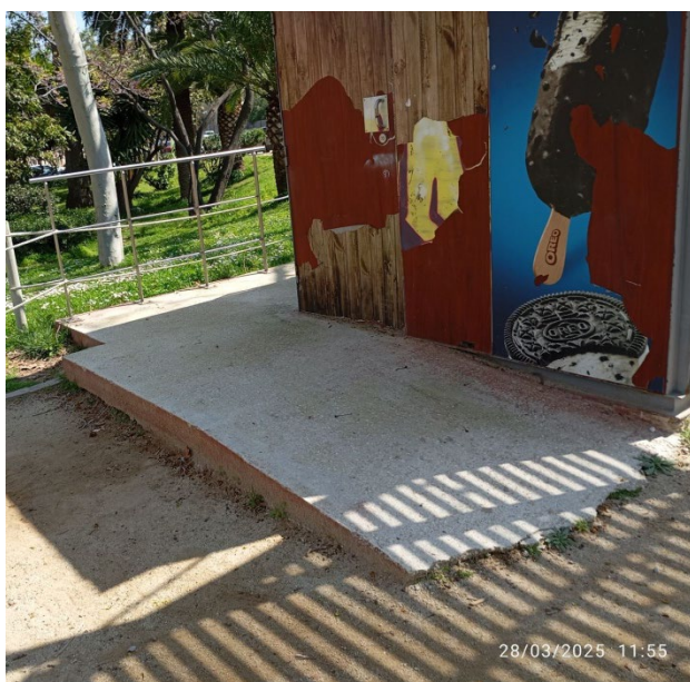
Imatge 4 i 5 Reparar i adaptar la rampa per l'accés al lavabo adaptat que presenta zones malmeses.
