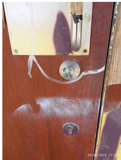
Imatge 2 i 3 Reparar o substituir els panys del lavabo i de la guingueta que han estat vandalitzats
